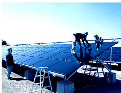
コンクリート基礎
