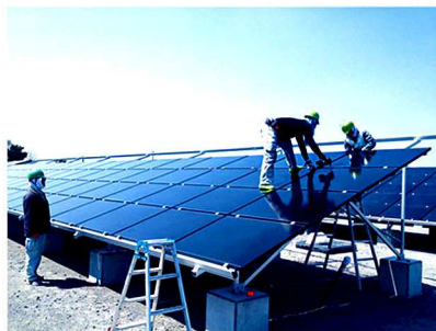
コンクリート基礎
