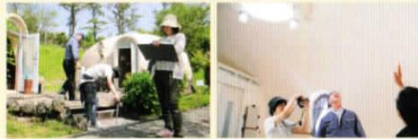
これからの中高齢化社会に向けて、ジャパンドームハウス株式会社と金沢工業大学は、地震・台風に強く、体にやさしく、安全な、防災型ハウスを共同開発することになりました。木材、鉄、コンクリートに次ぐ、今までにない第4の構造材「発泡ポリスチレン」でできており、これは国土交通大臣の認定も受けています。ドーム型の安定した構造に加えて、極めて軽量のため地震に強く、また、形状が流線型の半球体のため、台風にも安心です。さらに断熱性・気密性に優れ、高い省エネ効果を実現。腐ったり、錆びたりしないため、耐久性にも優れています。防災ハウスに適した住宅です。
